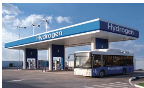
水素ステーション
